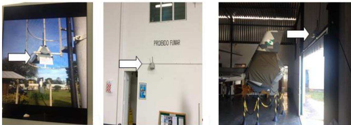
Figura 2 - Pontos de instalação da estação de monitoramento de poluentes atmosféricos. (A) pátio de manobras, (B) Hangar 12 e (C) Hangar 34. (Fonte: Acervo autor).
